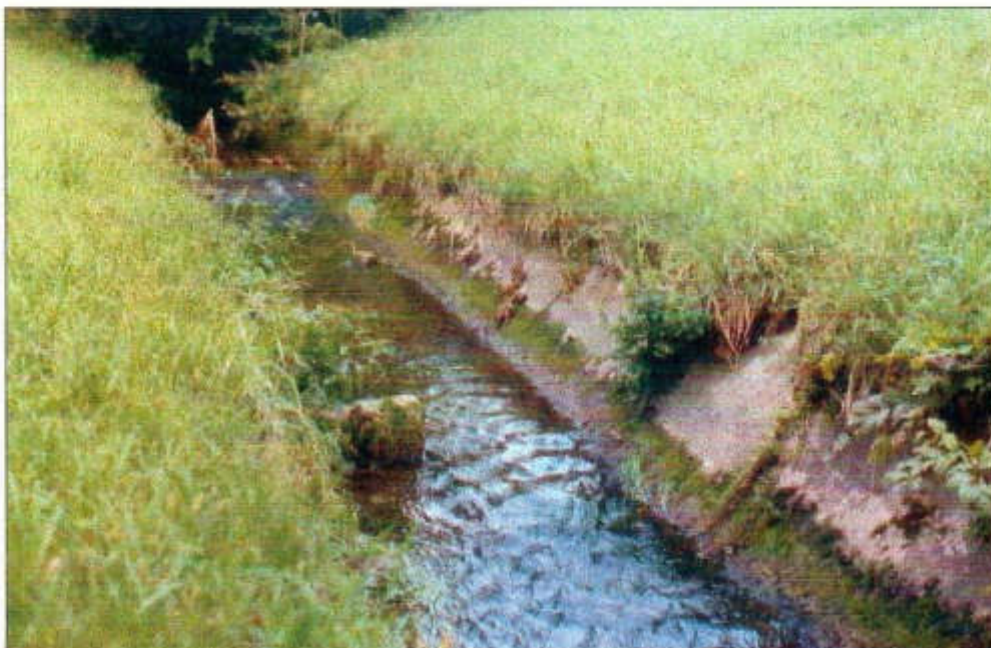
Ausbau des Hüttenbaches mit Betonschalen
